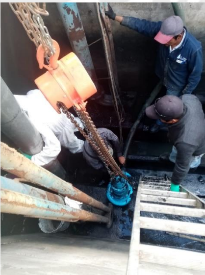
Fotografías 33, 34 y 35. Se observan las intervenciones que ha tenido la planta de tratamiento del municipio como desazolve y limpieza.
