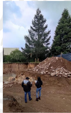
Fotografía 20. Dictamen de árbol en zona de construcción.
